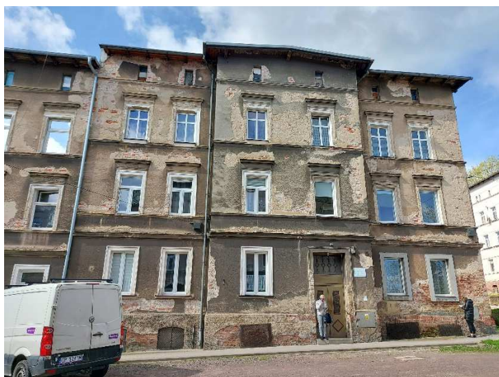
Elewacja frontowa budynku nr 279, 281, 283
