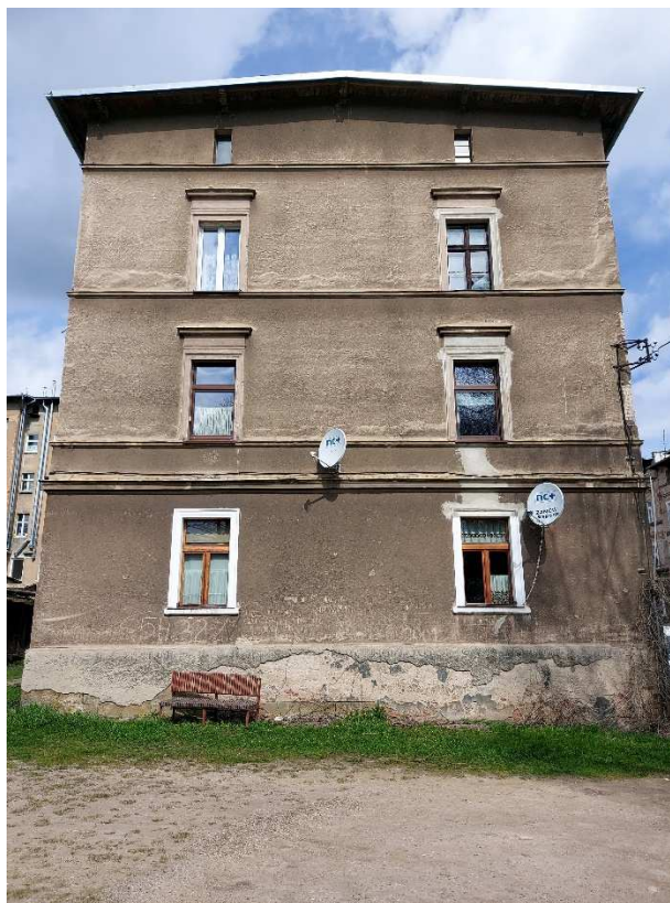
Elewacja boczna budynku nr 279, 281, 283
