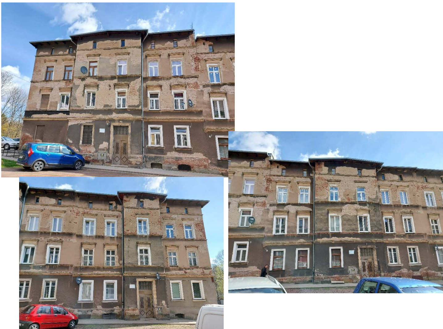
Elewacja frontowa budynku nr 273, 275, 277
