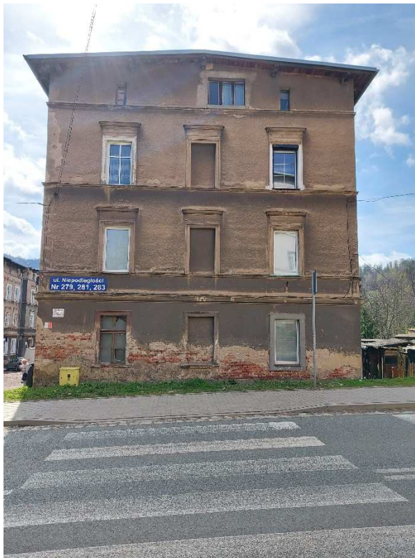
Elewacja boczna budynku nr 279, 281, 283
