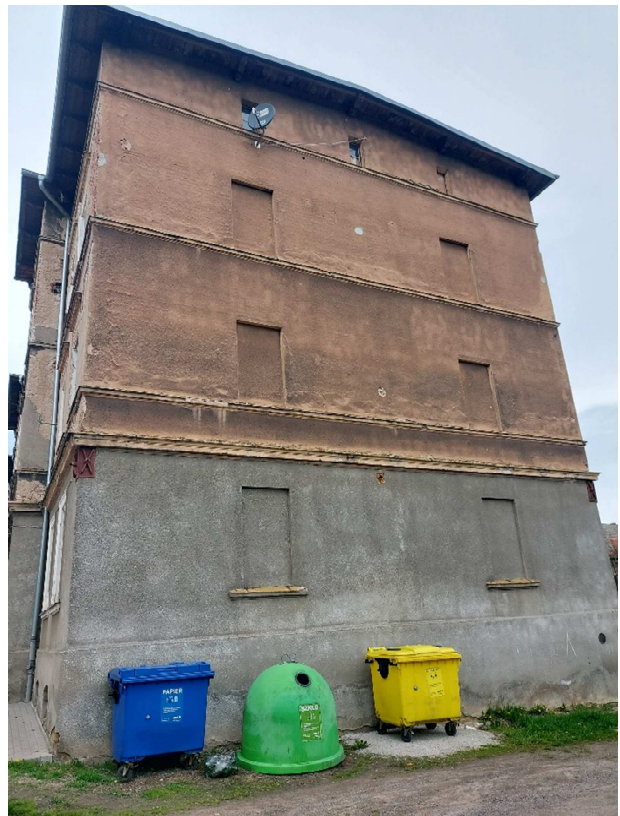
Elewacja boczna budynku nr 273, 275, 277
