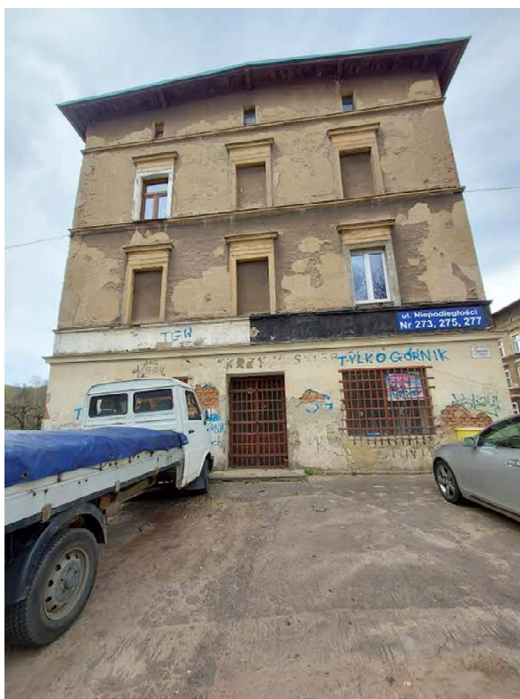
Elewacja boczna budynku nr 273, 275, 277
