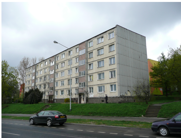
Fotografia 1 . Widok elewacji frontowej i bocznej
