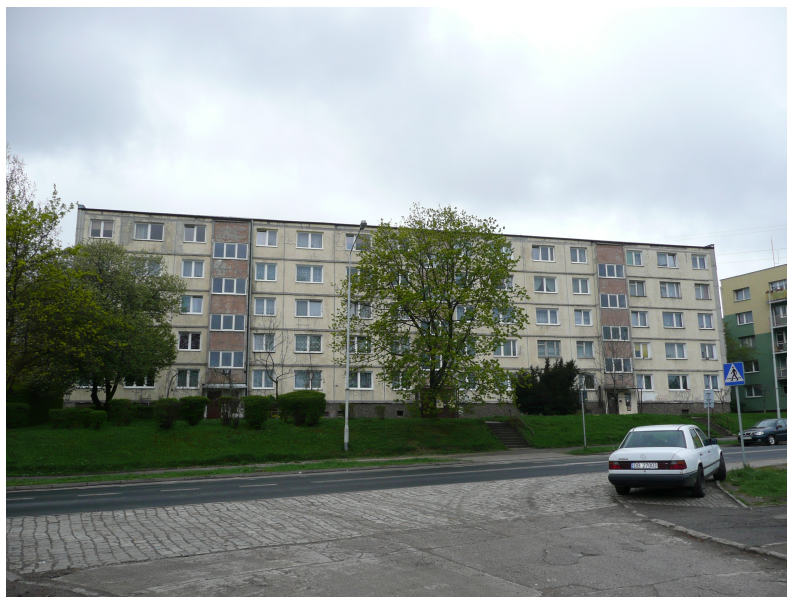
Fotografia 1 . Widok elewacji frontowej
