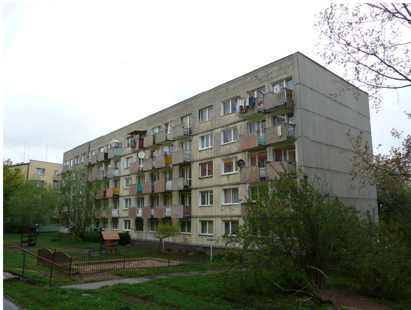
Fotografia 2. Widok elewacji tylnej
