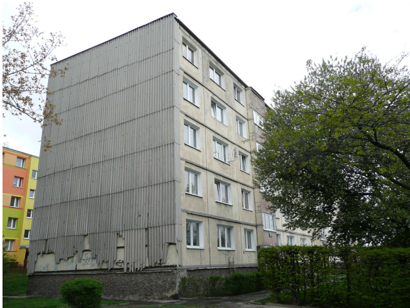
Fotografia 1 . Widok elewacji frontowej i bocznej
