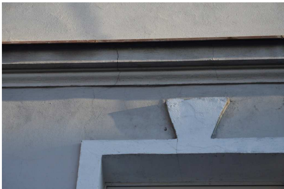
Fot. 3. Pęknięcia gzymsów na elewacji frontowej
