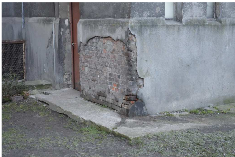
Fot. 4. Ubytki tynków na elewacji tylnej
